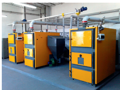
Kotłownia TAURON w Opolu 3x Bioplex 300 kW
